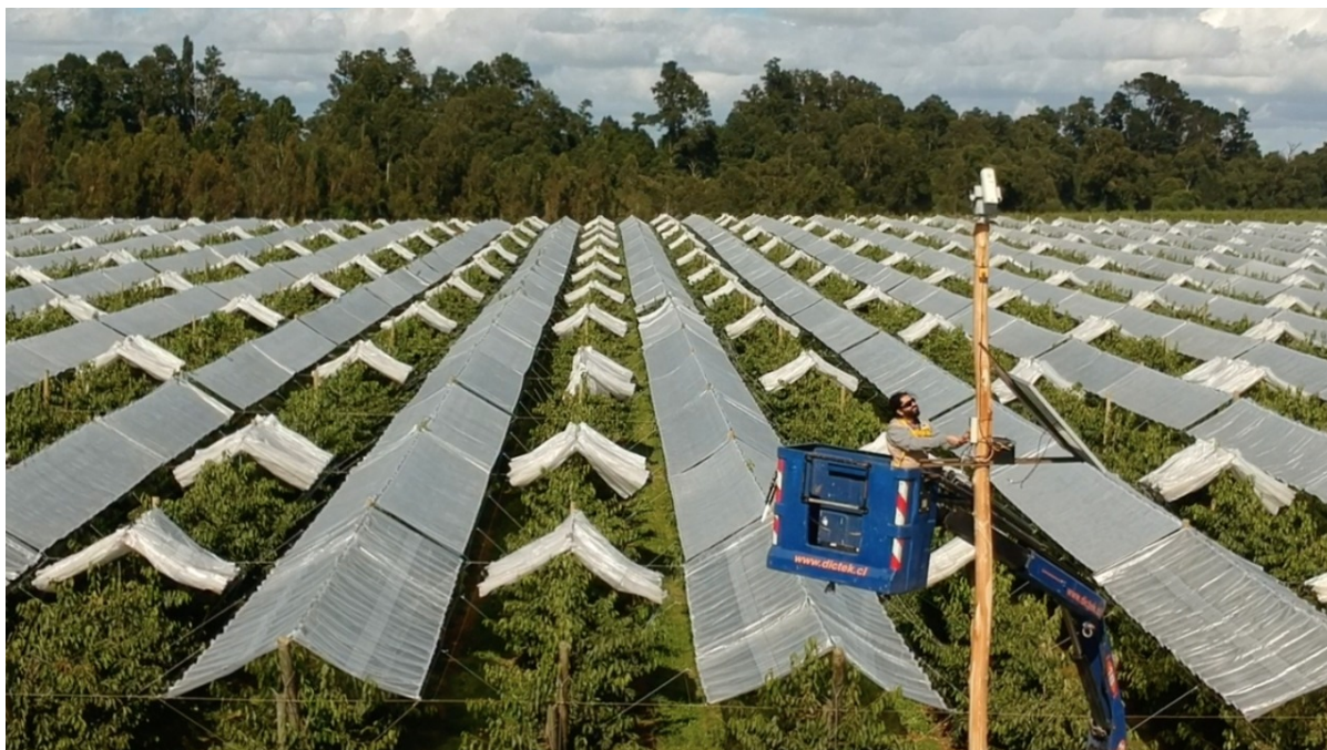
Técnicos de Grupo Laevo durante el proceso de instalación.
